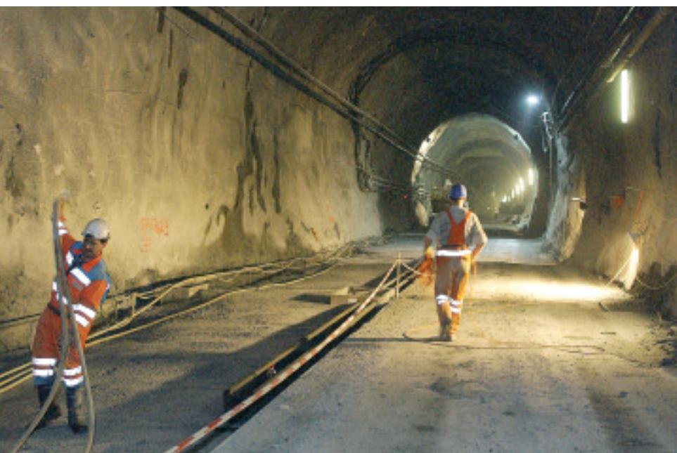
Tunnel à l'état de gros œuvre avec son radier bétonné.
