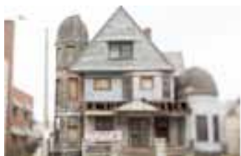
L'une des nombreuses maisons abandonnées et vandalisées à Cleveland, en raison de l'effondrement des crédits sur l'immobilier, en 2008.
