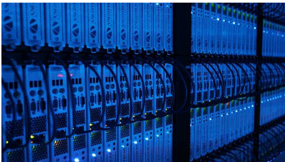
Vue partielle de la ferme de rendu des studios Pixar, située sur leur campus principal à Emeryville en Californie.
