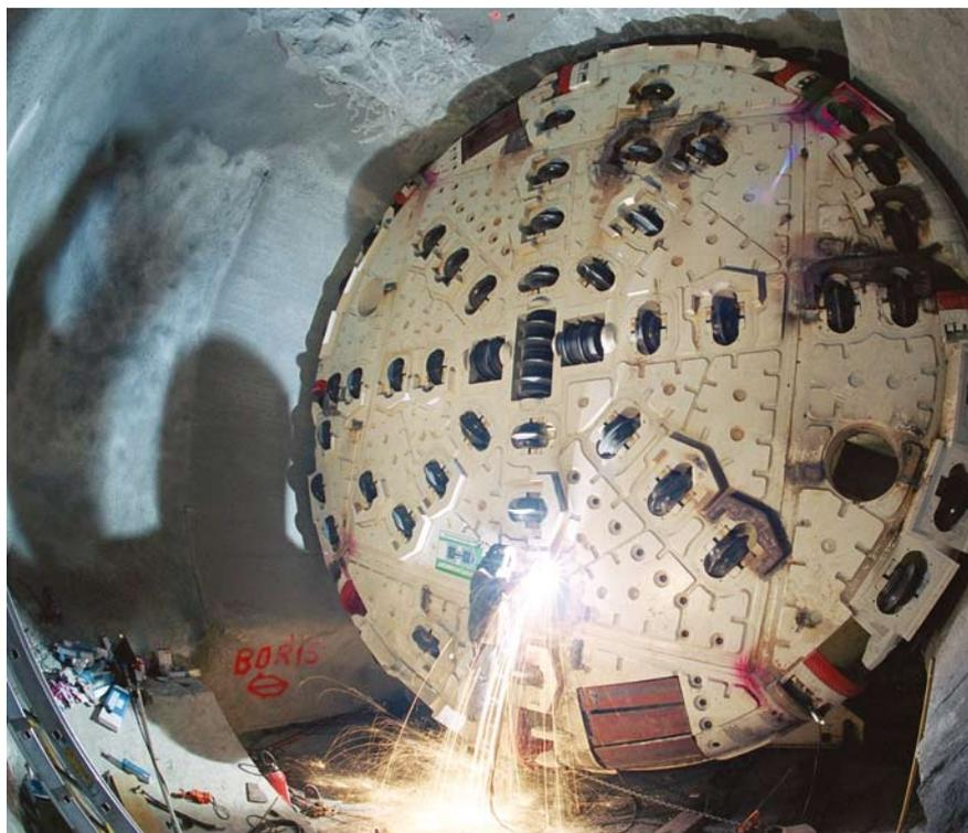
Montage d'un tunnelier à Bodio
