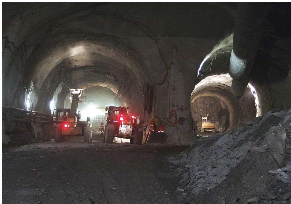
*Travaux de construction pour une diagonale d'échange au sein de la station multifonctions de Sedrun*
