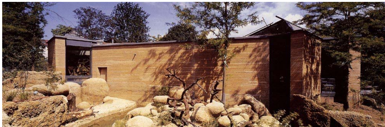
Pavillon Etoscha du Zoo de Bâle en Suisse. Murs en pisé, réalisés par Martin Rauch. Architecture de Peter Steiner © Bruno Klomfar
