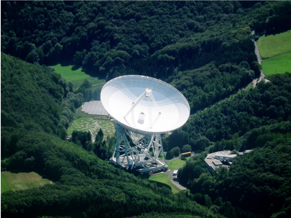
Vue aérienne du radiotélescope d'Effelsberg, géré par l'Institut Max-Planck de radioastronomie. Doté d'un diamètre de 100 m, il étudie les rayonnements venant du ciel entre 7 et 90 cm. Crédit : Dr. G. Schmitz.
